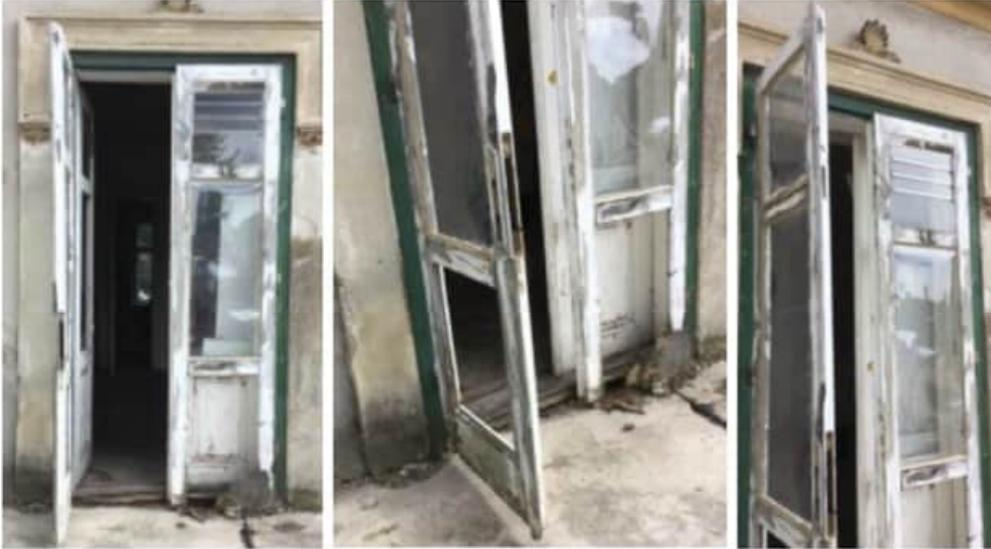
Ad 1): Außenflügel tlw. verfault, Füllungen und Wetterschenkel fehlen, Anstrich Flügeln und Stock schadhaft, Verglasung fehlt tlw.
