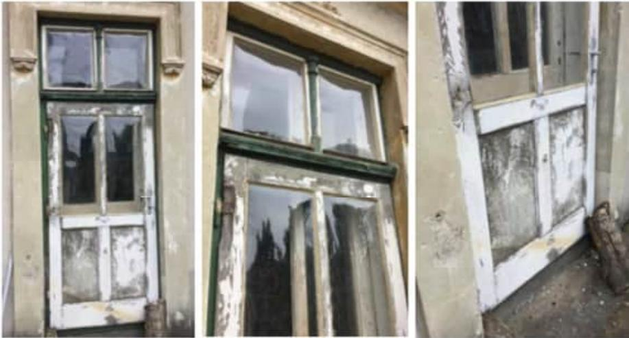
Ad 1): Außenflügel Füllungen erneuern, Bandseitiges Fries beschädigt, Anstrich Flügeln und Stock schadhaf
